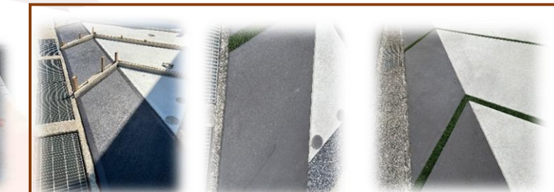
ブラックコンクリート 施工事例と完成写真
