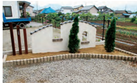
ピンコロで縁取りをした花壇を施工しました。アクセントで天然木スリットと塗仕様の塀も施工し、立体的に変化のある花壇になりました。
