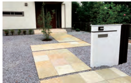
距離のあるアプローチに大判の天然石を施工しました。門柱と植栽を施し動線の変化にもこだわりました。
